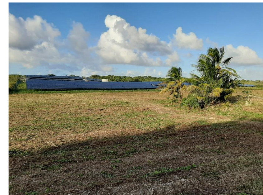
Figure 5 : Parc solaire construit en 2018
